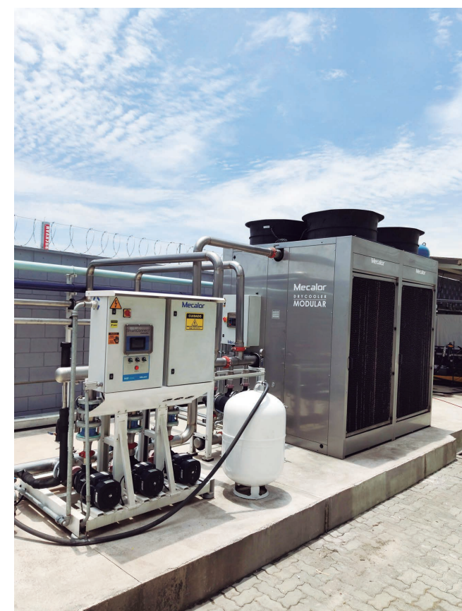
Instalação de um Drycooler Mecalor
